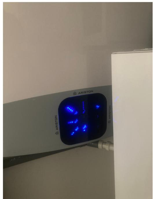
**Le chauffe-eau électrique dispose également un tableau de commande tactile et intelligent pour visualiser le nombre de douches disponibles, la température de chauffe, la programmation quotidienne et le minuteur.**
